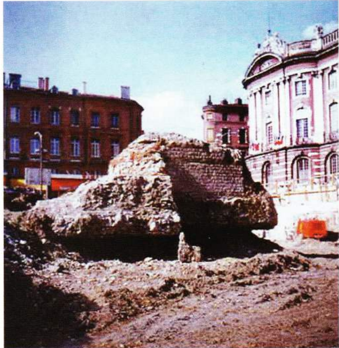
FIG. 5. DESTRUCTION DU DÉPART DE LA COURTINE ORIENTALE EN 1971. Cliché Michel Vidal.
