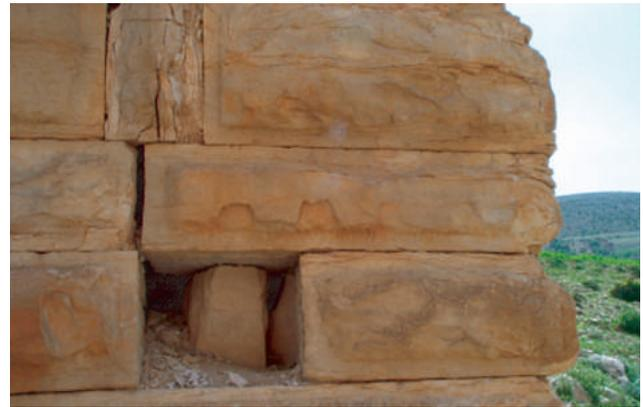
Fig. 15. Le pont sur l'oued Krafès, le bossage d'économie conserve les traces d'extraction en carrière.
