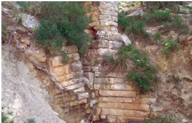
Fig. 9. Le pont-aqueduc en aval d'aïn Djebour, la pile effondrée de la rive droite et l'arrière-bec de la pile de la rive gauche.
