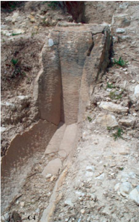
Fig. 14. La chute en amont du pont-aqueduc et le départ de la canalisation C4.
