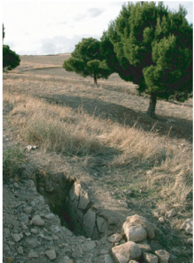
Fig. 36. Le décollement du mortier étanche et les concrétions calcaires.
