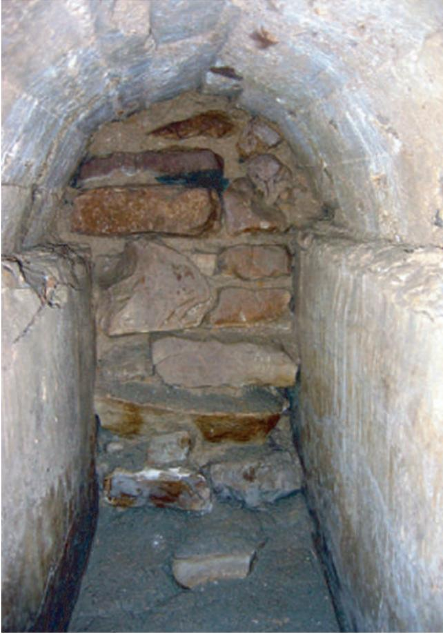
Fig. 42. L'obstruction du canal C1.
