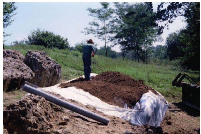
Fig. 19 : Fragment A1, mise en place d'une protection (matelas végétal posé sur un géotextile) (2005).
