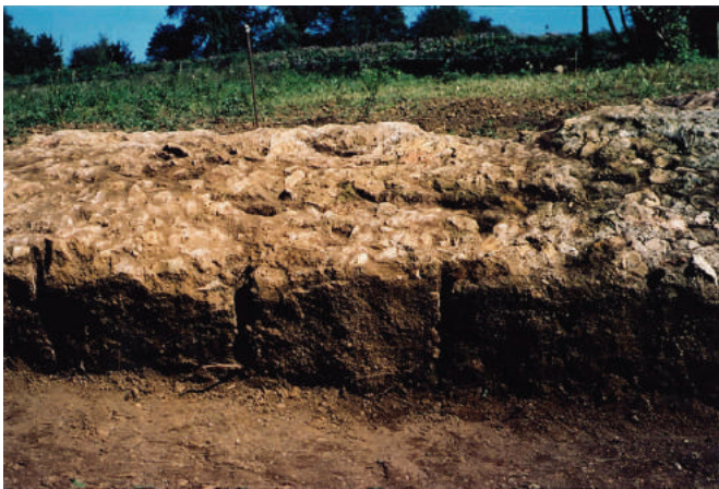
Fig. 11 : Fragment An, détail de la partie inférieure, avec l'alignement des trous au bas d'une banchée.
