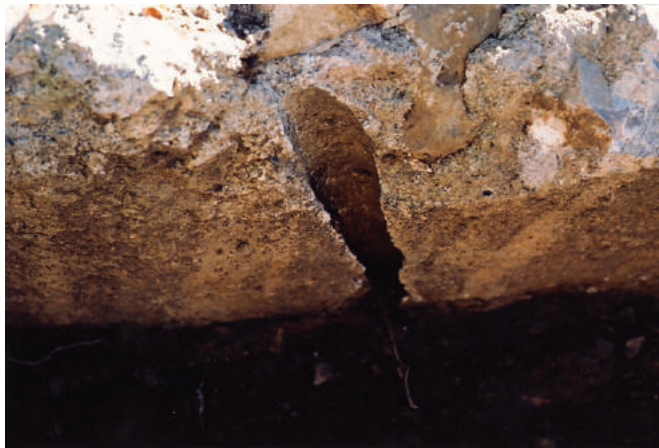
Fig. 12 : Trace d'entretoise dans le lit de mortier de pose du fragment An.
