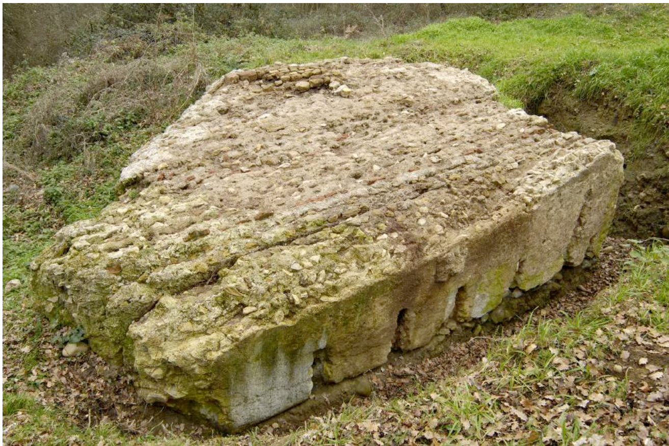
Fig. 14 : Fragment B3, conservant le sol du chemin de ronde avec la trace des traverses du parapet et l'empreinte des pièces de bois saillantes en porte-à-faux sur la face interne de la courtine.
