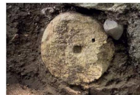
Fig. 59. Tambour de colonne réemployé pour conforter les fondations de la courtine C (photo MAS'L).
