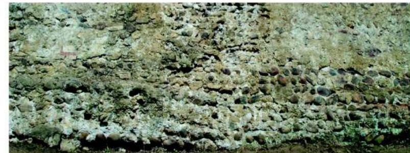
Fig. 89c. Fondations déchaussées de la courtine 199 : les rangées inférieures de galets épousent le relief du terrain.
