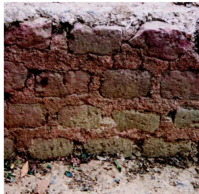
Fig. 82. Joints beurrés au mortier de chaux à forte teneur en tuileau dans la tour 212 (photo MAS'L).
