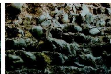
Fig. 89b. Fondation de la courtine D : rangées régulières de galets calibrés liés avec un mortier insuffisant et trop maigre.
