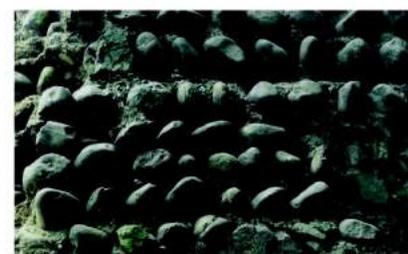
Fig. 89a. Fondation déchaussée de la courtine C : rangées régulières de galets calibrés.
