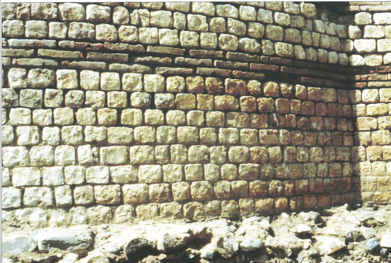
FIG. 62. TOUR DE L'ENCEINTE À L'ANCIEN HÔPITAL LARREY. Soubassement en petit appareil coupé aux deux tiers par un chaînage de briques. Cliché R. De Filippo.
